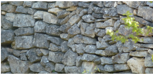
Référence de murets en pierre sèche
